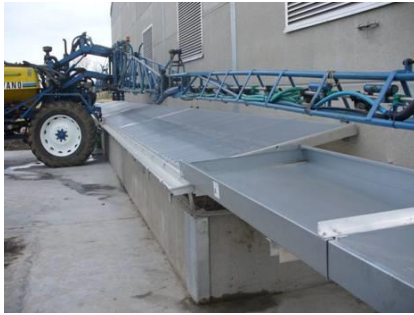
Figuur 12: Reinigen spuitboom op dakconstructie fytobak
