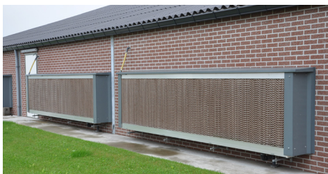
Pad koeling voor de luchtinlaat
