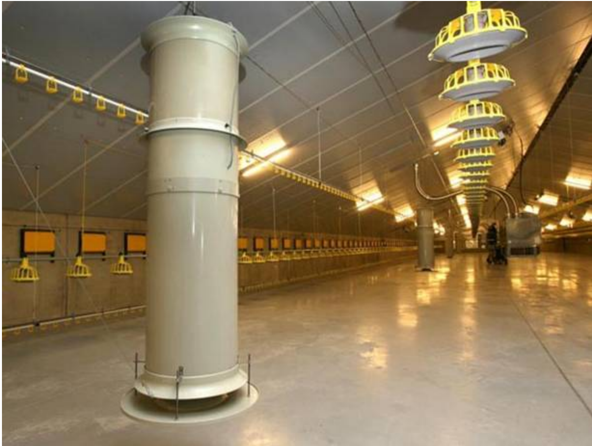
Figuur 30 Mixluchtsysteem (bron: Boerderij)
