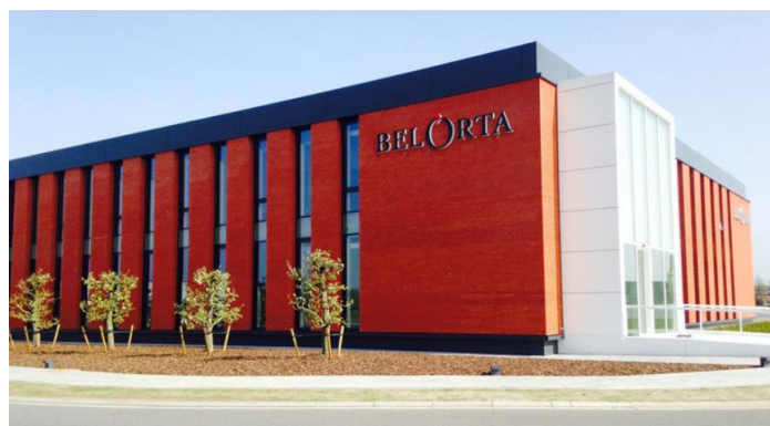
Figuur 30. Kantoorgebouw van BelOrta te Sint-Katelijne-Waver
