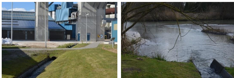
Figuur 16. Warme koelwater dat uit de fabriek (links) in Osseput 1 (rechts) vloeit
