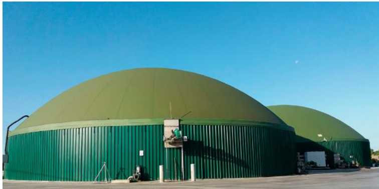
Figuur 46. De biogasinstallatie van Agro-Energiek
