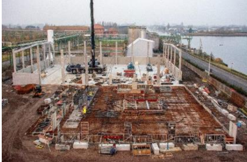
Figuur 68. Vorderingen werkzaamheden van de installatie bij Farys te Oostende (Bart De Gusseme)
