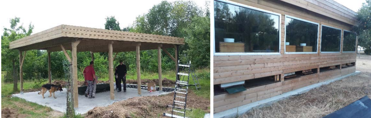
Figuur 1: Links: de opbouw van bijenhal in “De Panoven” te Halen. Rechts: 6 bijenvolken geïnstalleerd in de nieuwe bijenhal.
